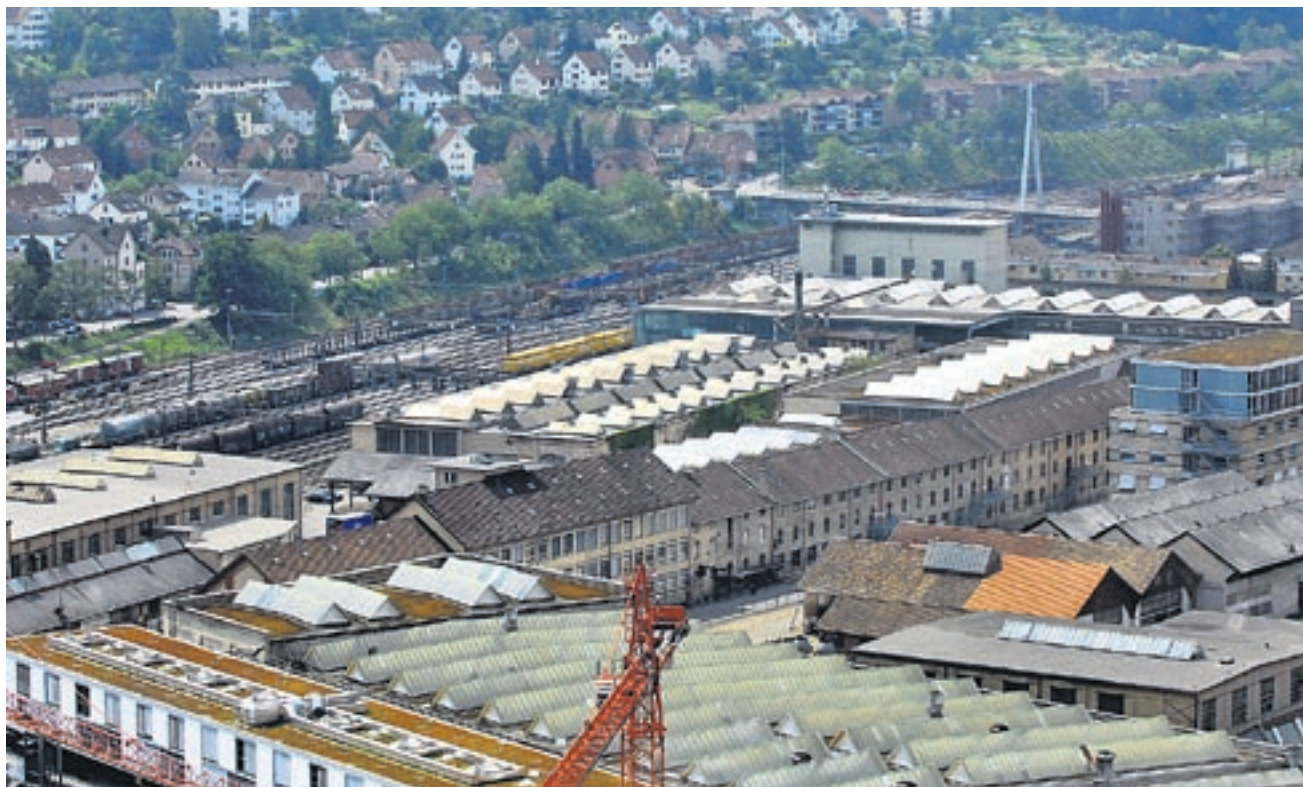
Das 50 000 Quadratmeter grosse Lagerplatz-Areal soll ein urbanes Zentrum werden und seinen Industriecharme behalten. Bild: mad
